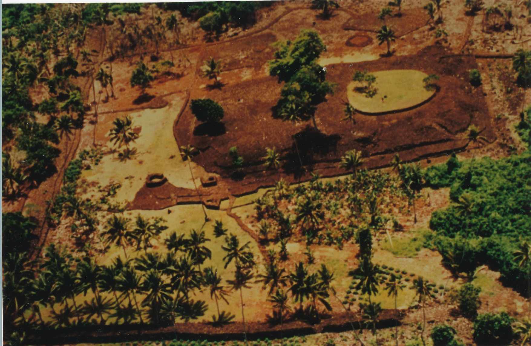
Tukituki o Kolonui / Talietumu (Loto'alahi, Mu'a) travaux de restauration Daniel Frimigacci.
